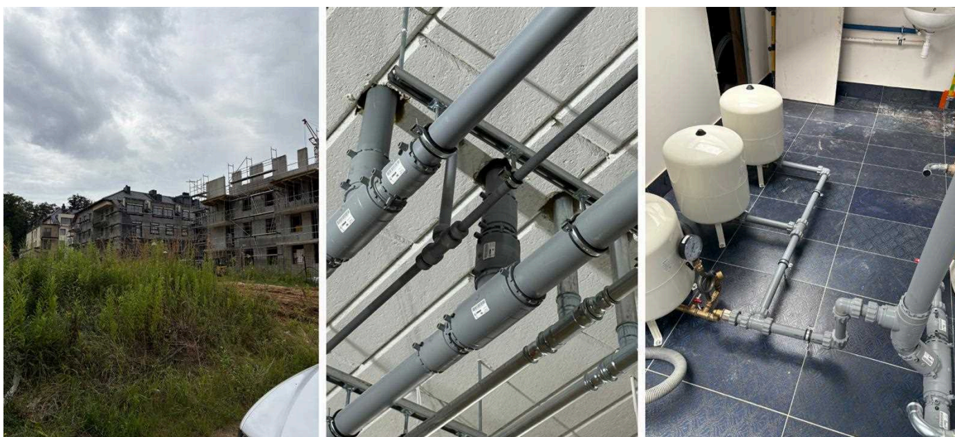
Rys. 9. Przykłady instalacji z polibutylenem
