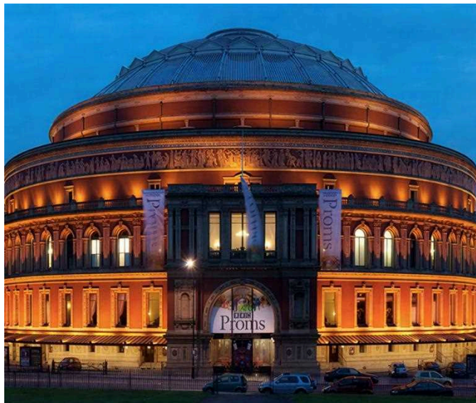
Rys. 7. Wymiana instalacji w The Royal Hall polegała na zastąpieniu 1 000 m.b. rur stalowych rurami z polibutylenu
